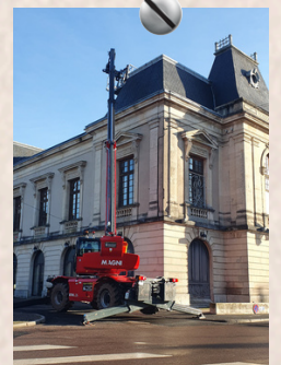
Réparation de la toiture de la salle des fêtes
