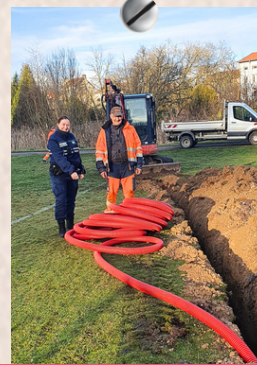
Pose de luminaires au stade
