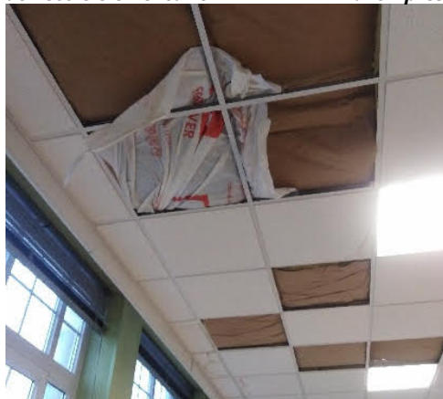
Réfection du faux-plafond de l'école élémentaire
