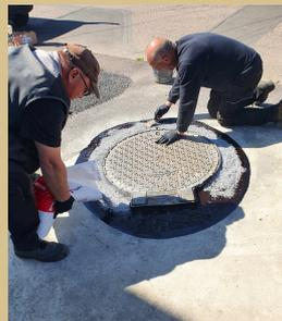
✓ Mise à niveau avec tampon du poste de refoulement Rue d'Harbouey
